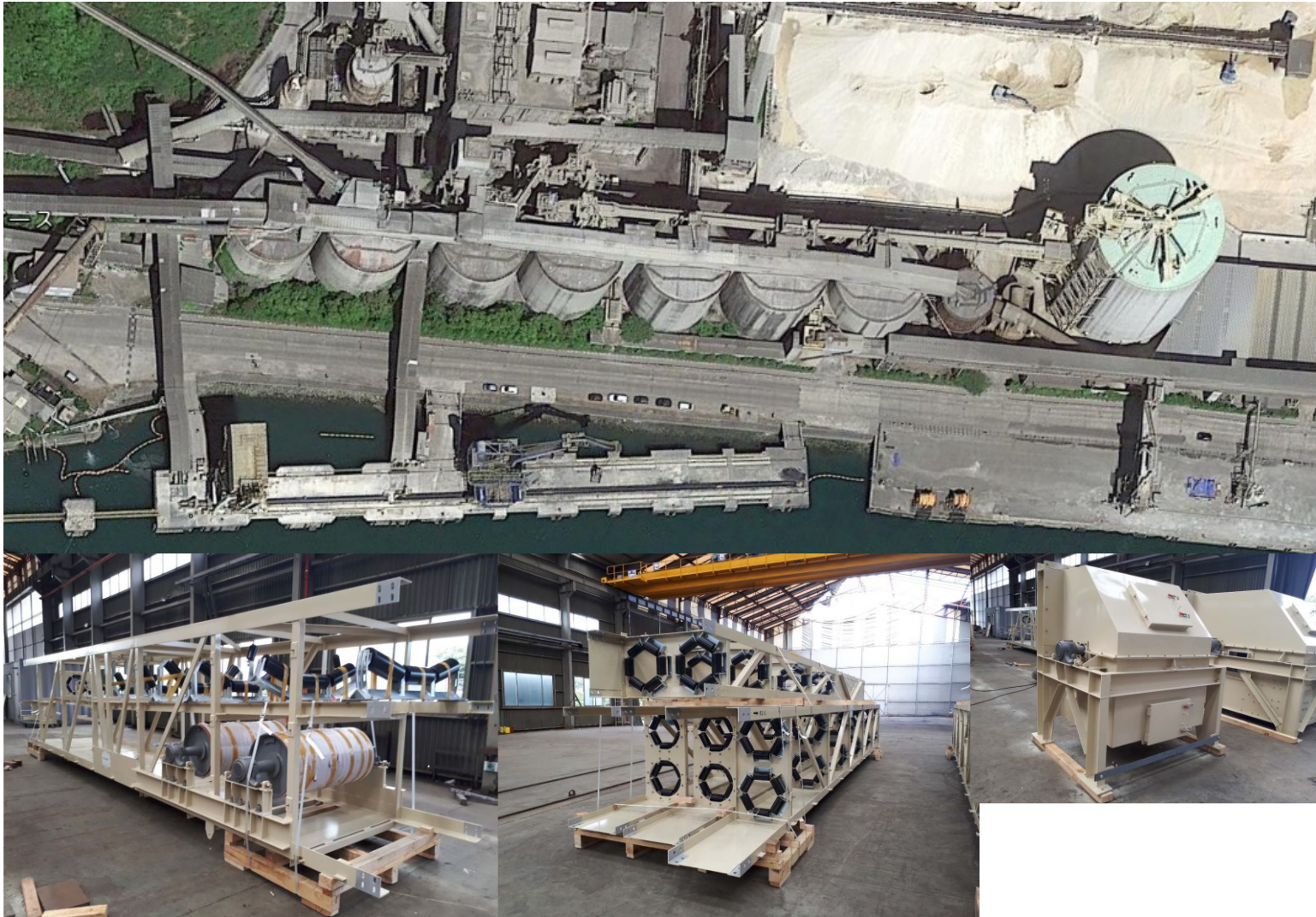
[일본, 스미토모오사카시멘트 고치공장 파이프 컨베어]
